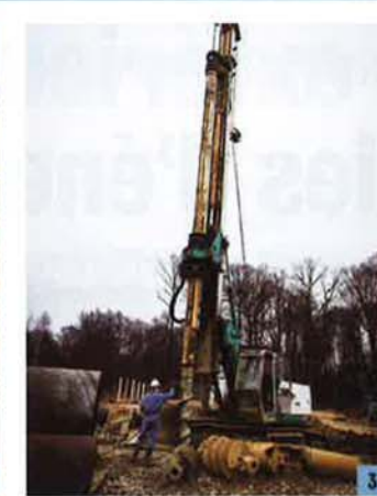
1. LACS. Le creusement de deux lacs a suscité 450 000 m 3 de terrassements, réemployés dans des merlons antibruits. 2. RU DE LA FOLIE. Deux rus, dont celui de la Folie en cours de renaturation, collecteront les eaux pluviales. 3. GÉOTHERMIE. Le forage engagé en février fournira l'énergie consommée par le site touristique et les territoires environnants, y compris le parc Eurodisney. 4. AQUALAGON. De l'extérieur, la pyramide plantée servira de promenade. Jacques Ferrier a conçu le bâtiment paysage, icône du projet qui cherche à réconcilier nature et culture.
