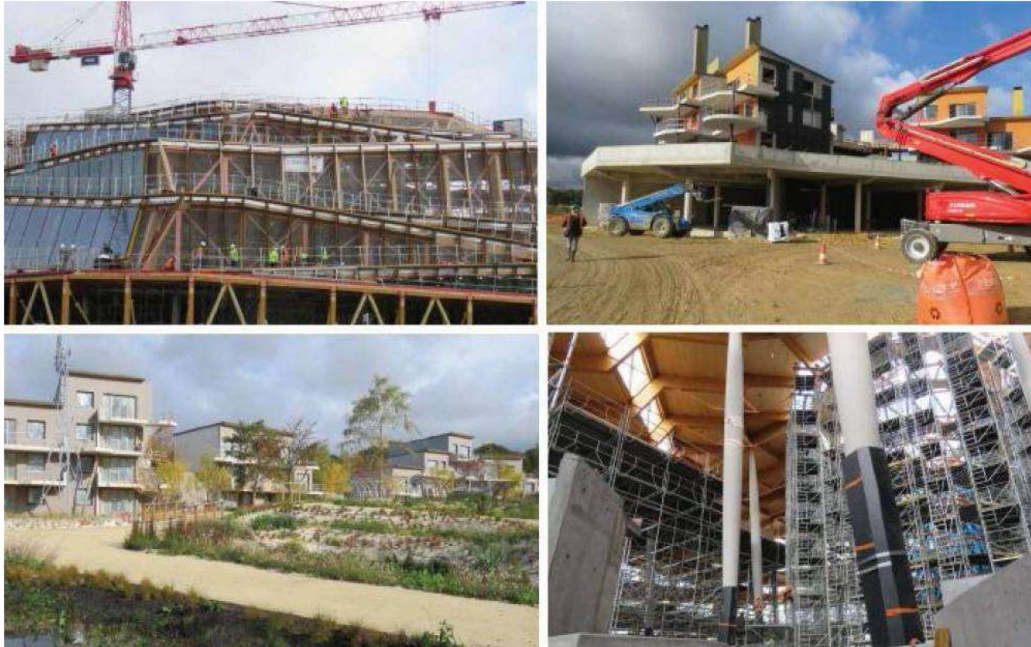
Villeneuve-le-Comte, 18 octobre. Les 868 premiers hébergements de la première phase sont pratiquement terminés. Les 450?000 plantes vont être mises en terre dès novembre. En attendant, les ouvriers travaillent sur le cœur du projet : l'Aqualagon (en haut à gauche et en bas à droite). LP/M.K.
